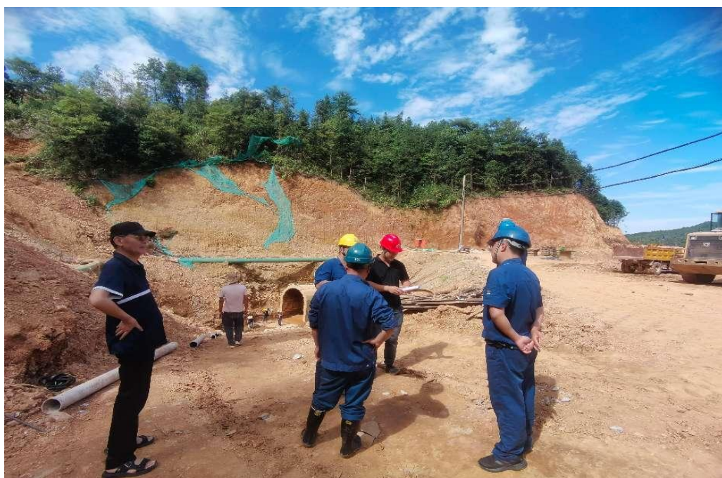
图 2-8 斜槽和明洞基础验槽
