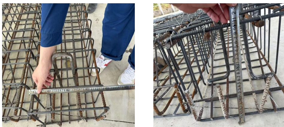
图 2-13 斜槽盖板钢筋绑扎验收
