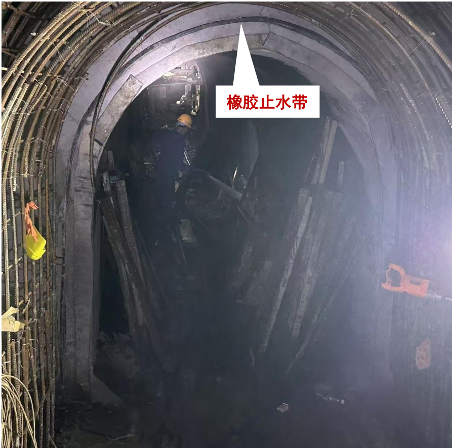
图 2-26 橡胶止水带安装
