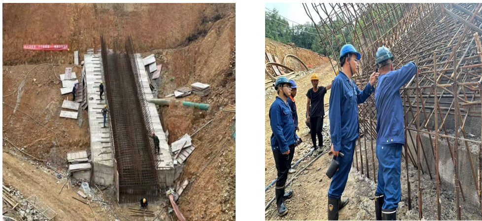
图 2-12 斜槽段钢筋绑扎验收
