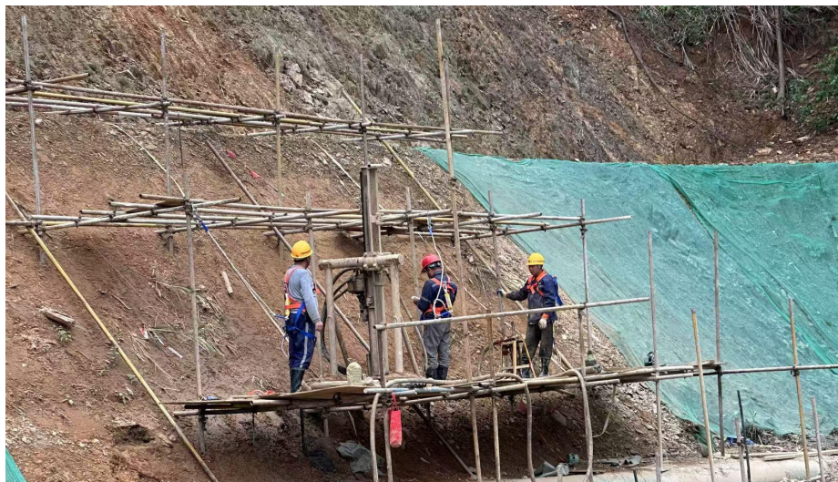
图 2-9 斜槽基础固结灌浆孔注浆施工
