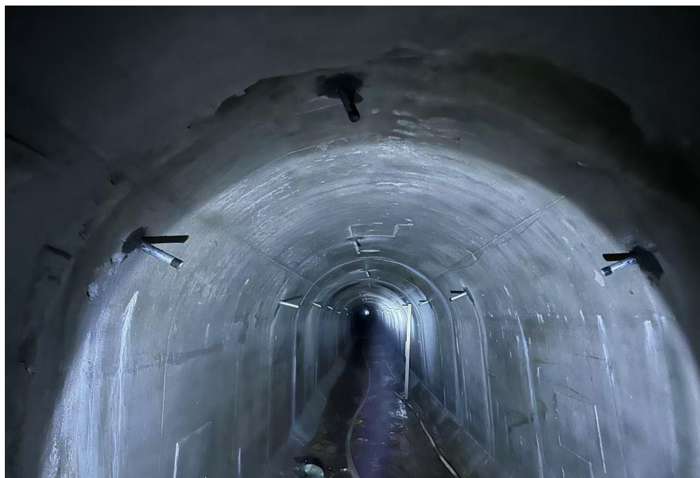
图 2-23 排洪隧洞灌浆后观感
