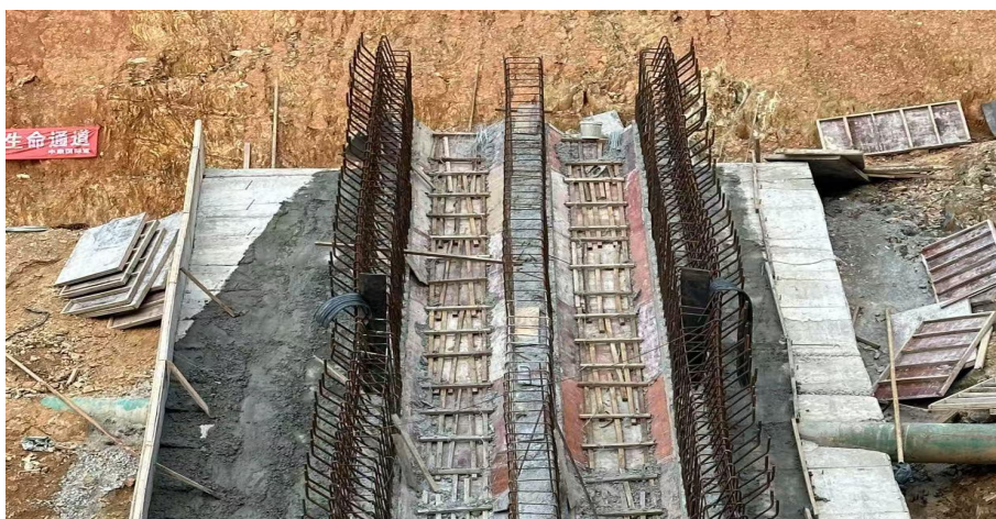
图 2-14 斜槽段止水带安装
