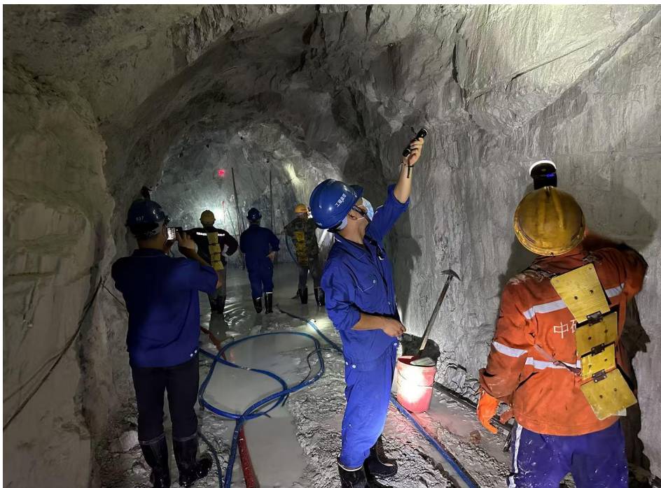
图 2-18 排洪隧洞掘进施工
