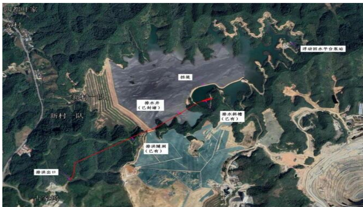
图 2-3 枫树岭尾矿库现状及周边环境卫星图
