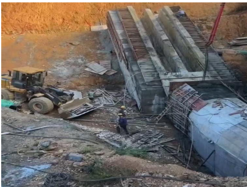
图 2-16 明洞砼浇筑
