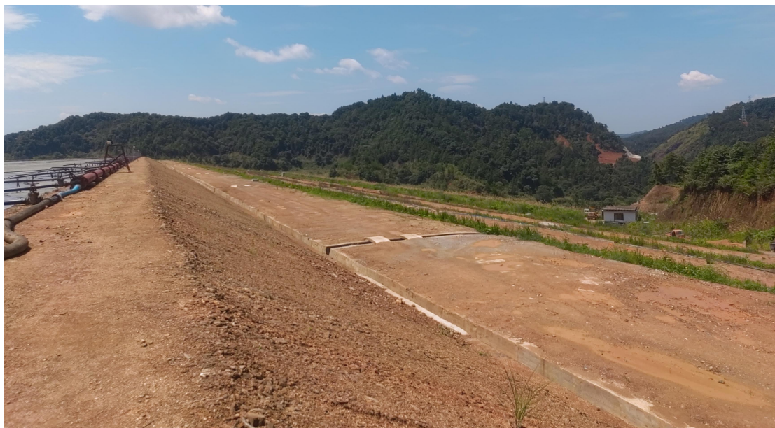
图 2-5 尾矿堆积坝照片
