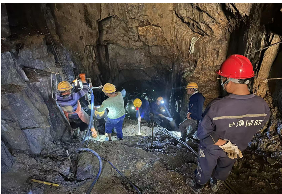
图 2-19 D1 型隧洞陡坡段围岩施工锚杆
