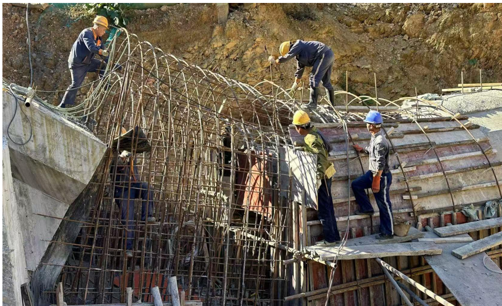
图 2-15 明洞钢筋绑扎
