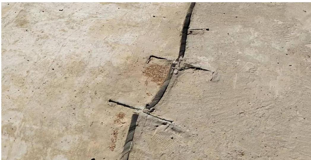
图 2.4.4-14 止水铜片、橡胶止水带、泡沫板后安装照片
