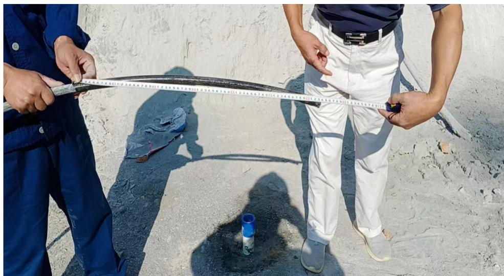
图 2.4.4-7 枫 3#坝灌浆孔验孔
