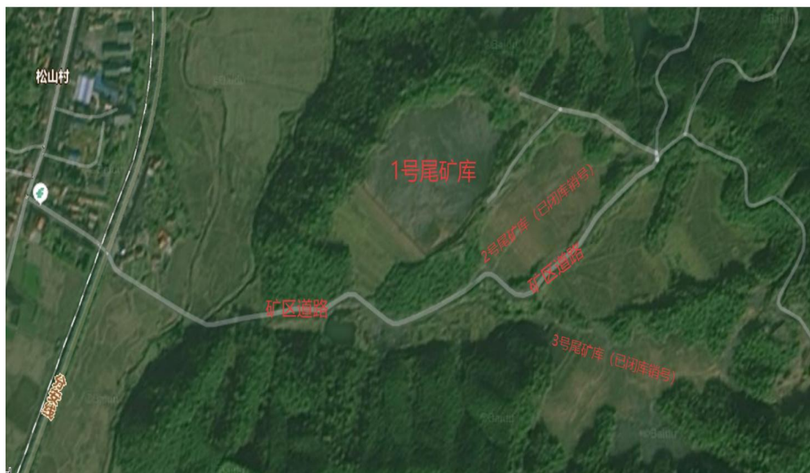
东杭矿业 1、2、3 号尾矿库卫星云图
