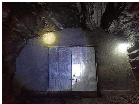
一矿区±0m 中段废弃巷道封堵
