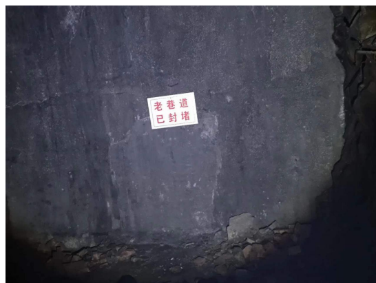
一矿区+50m 中段废弃巷道封堵
