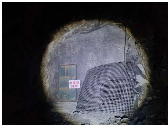
一矿区+100m 中段废弃巷道封堵
