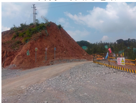
安全警示牌与初期坝联络道路
