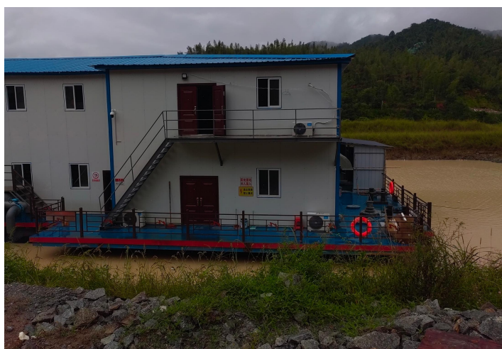
照明灯、救生圈、视频监控仪
