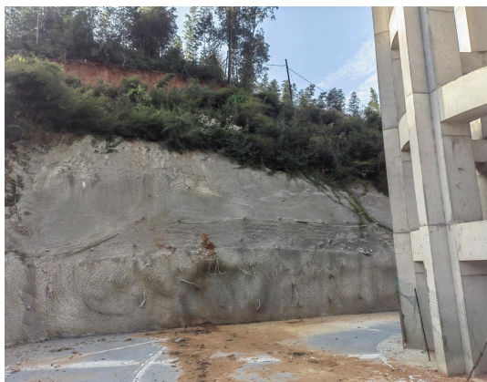
1#排水井山坡护坡
