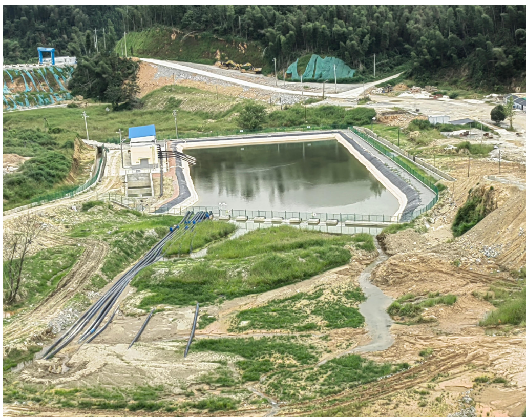
初期坝下游导排管与渗水回收池
