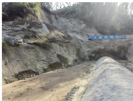
排水隧洞洞脸护坡
