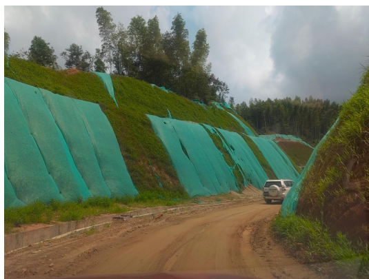
库区道路山坡护坡
