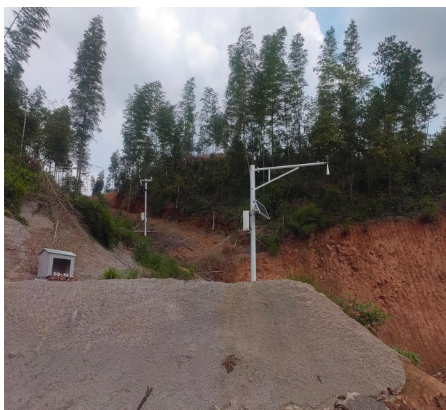
1#排水井视频监控仪、库水位监控仪
