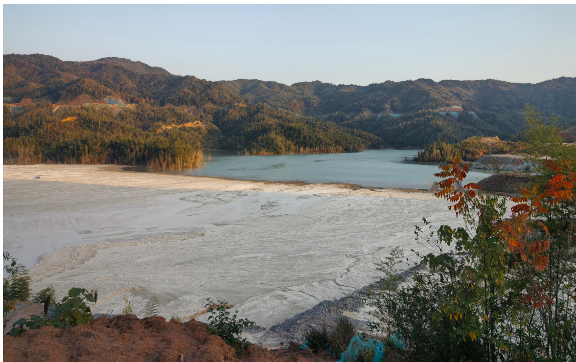
白源村尾矿库库内现状图
