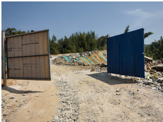
二期坝坝顶联络道路
