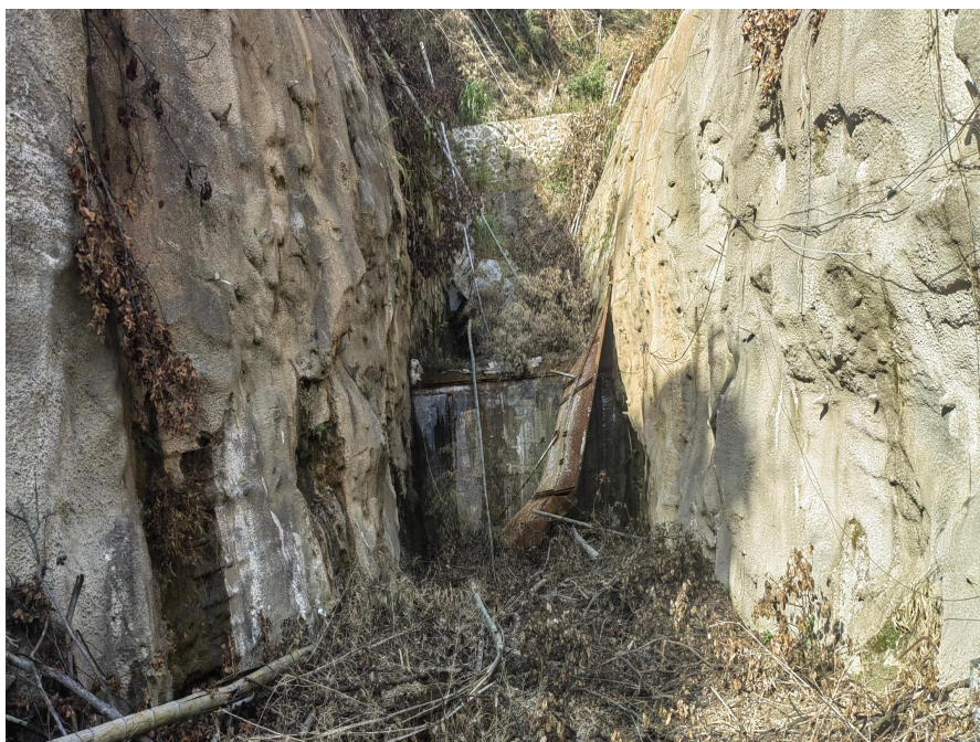
原郭家矿 225m 平硐封堵后现状
