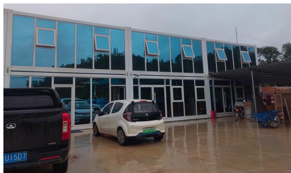
白源村尾矿库管理站
