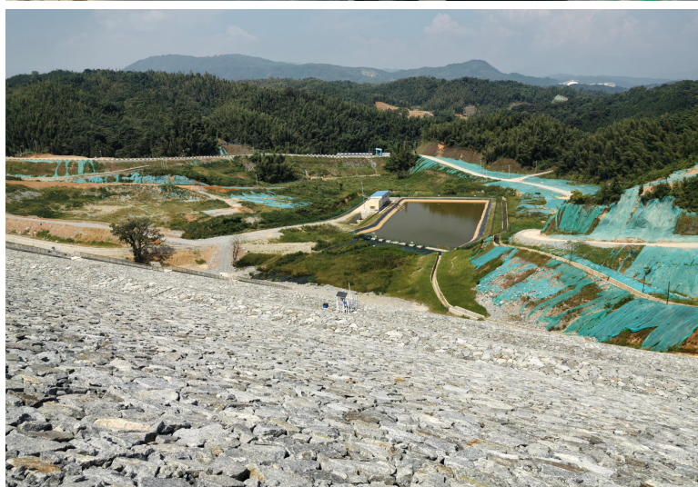
白源村尾矿库上下游现状图
