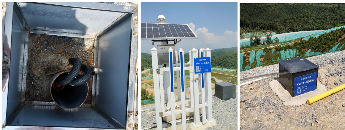
自左而右依次为在线浸润线、表面位移、内部位移监测仪
